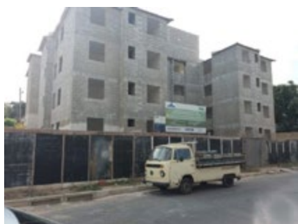
Condição dos imóveis do plano do reassentamento das famílias moradoras do entorno do Córrego Ferrugem durante vistoria realizada pela DPMG em 2018
