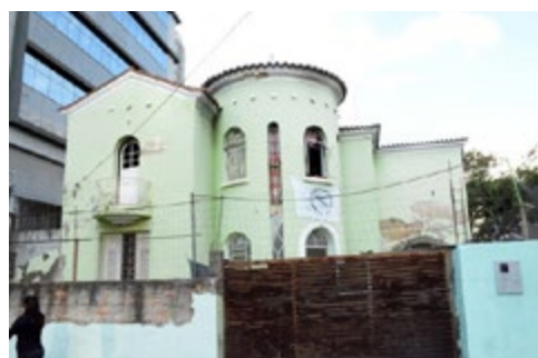
Imóvel localizado na Avenida Olegário Maciel foi batizado de Ocupação Casa Verde Foto: Marcelo Sant'Anna/DPMG
